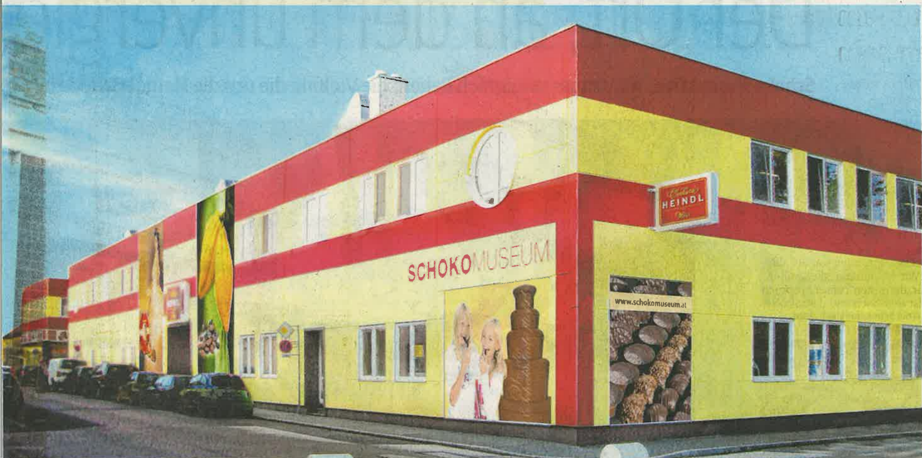
HEINDL Einst und jetzt: Als Maria und Walter Heindl ihre Schokoladefabrik gründeten, reichte ein kleines Einfamilienhaus. Heute umfasst die moderne Firmenzentrale mehr als 12.000 Quadratmeter
